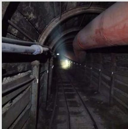
AVANCE JACKLEG SECCION 2.7 X 2.7 M
