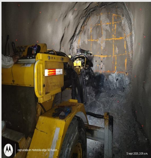
PERFORACION CON JUMBO SECCION 3.5 X 3.5 M
