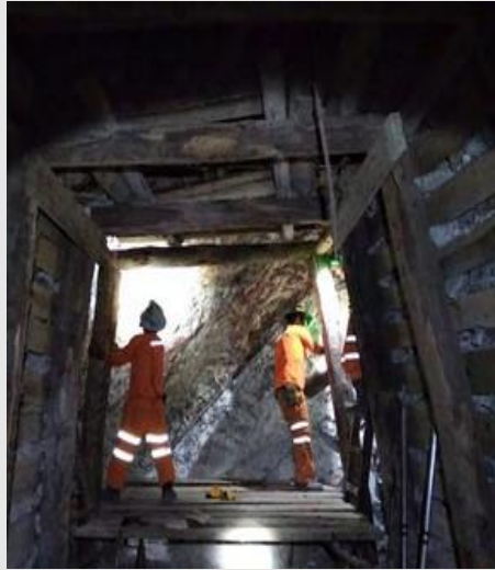
SOSTENIMIENTO CON CUADRO DE MADERA
