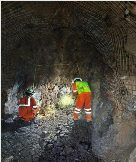
SOSTENIMIENTO CON MALLA
