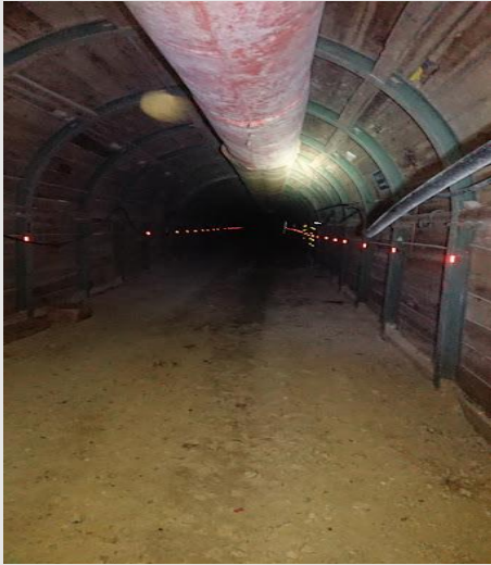
SOSTENIMIENTO - DE AVANCE 3.5 X 3.5 M
