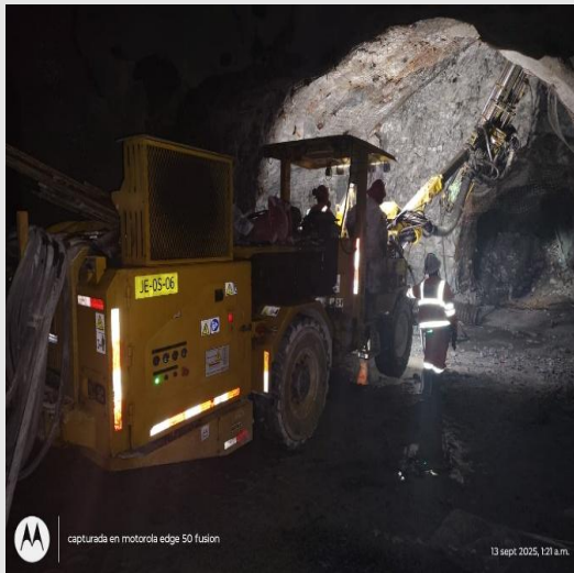
SOSTENIMIENTO CON BOLTER SECCION 4.0 X 4.0 M
